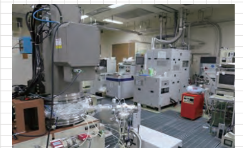
先端技術共同研究施設のクリーンルーム Clean room of the facility
