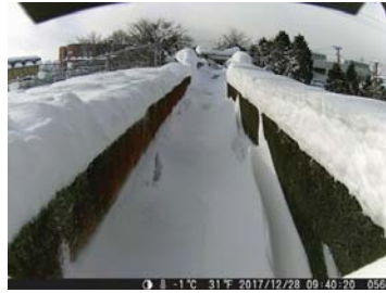
図2 雪で覆われた開水路
