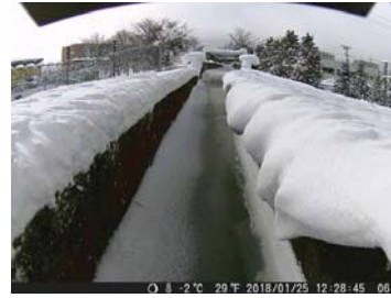
図5 左岸の雪庇の張り出し (図4から24時間後)
